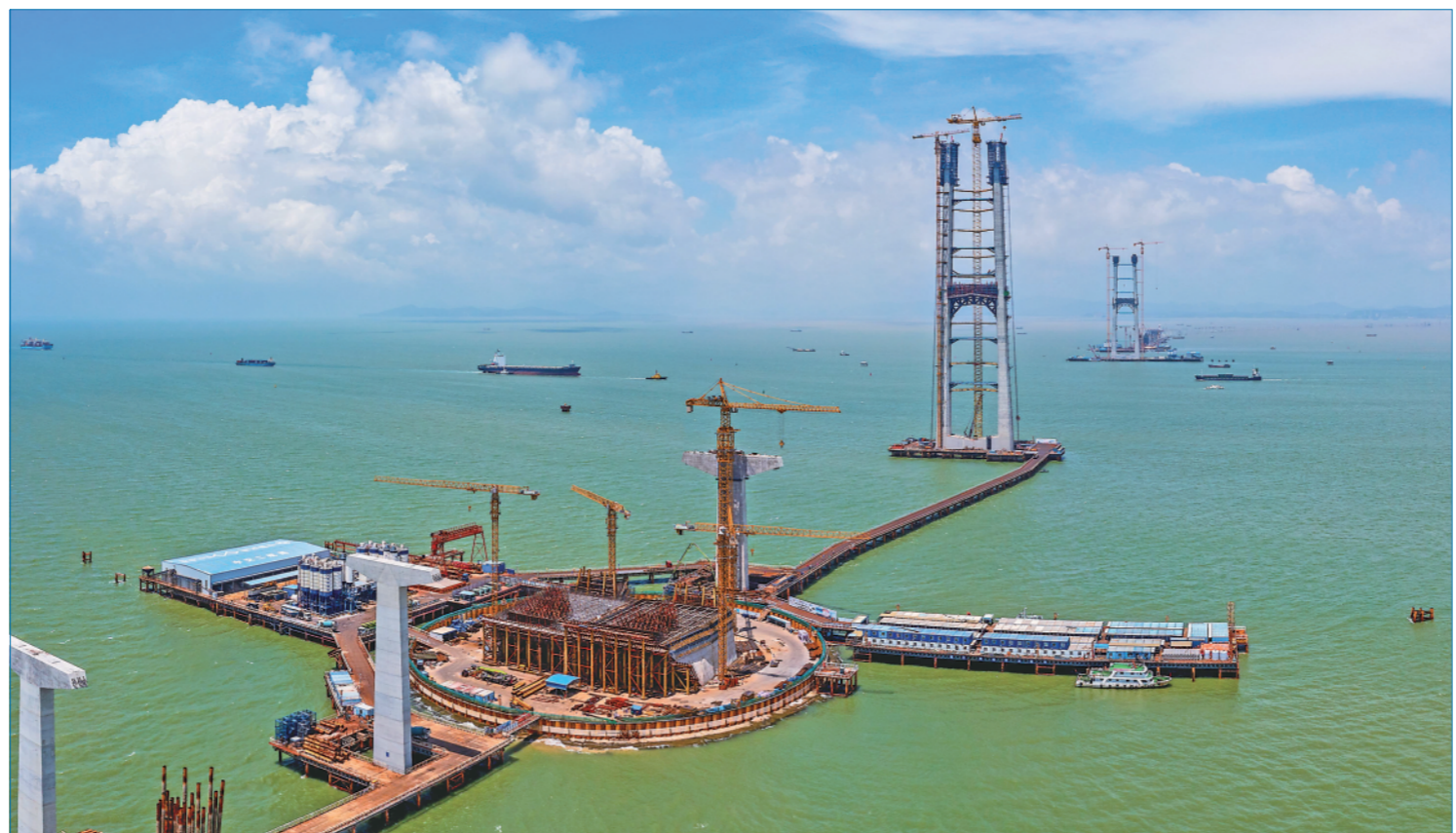
伶仃洋大桥东索塔封顶
