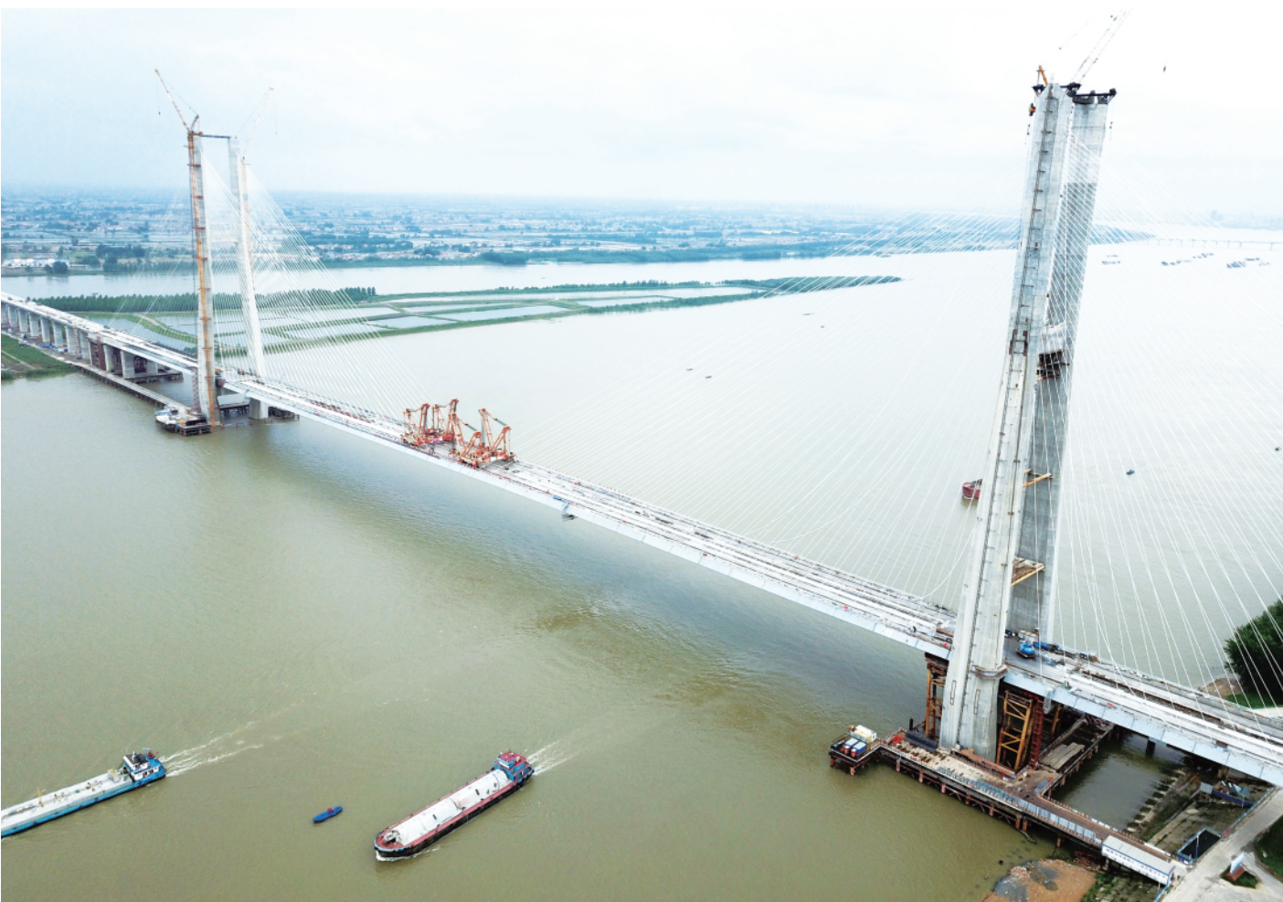
六月三日,安九铁路鳊鱼洲长江大桥合龙。大桥北侧位于湖北黄梅,南侧位于江西九江,高铁线时速三百五十公里,预留客货线时速两百公里。新华社记者程敏摄
