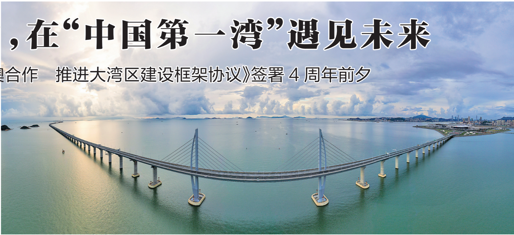
这是2020年9月12日拍摄的港珠澳大桥(无人机全景照片)。 新华社记者陈晔华摄
