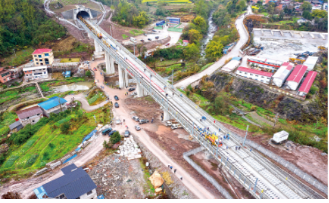
3月1日,随着第一组500米长钢轨铺入无砟轨道,郑万高铁重庆段铺轨工程正式启动。新华社记者唐奕摄
