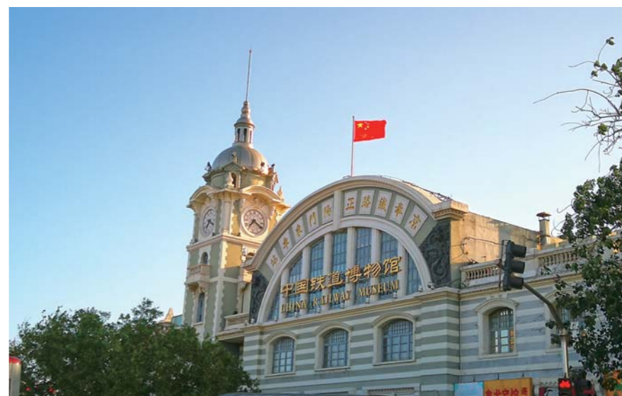
创新、体制改革等方面均开创了新局面。”中国铁道博物馆正阳门展馆副馆长周伟说。
