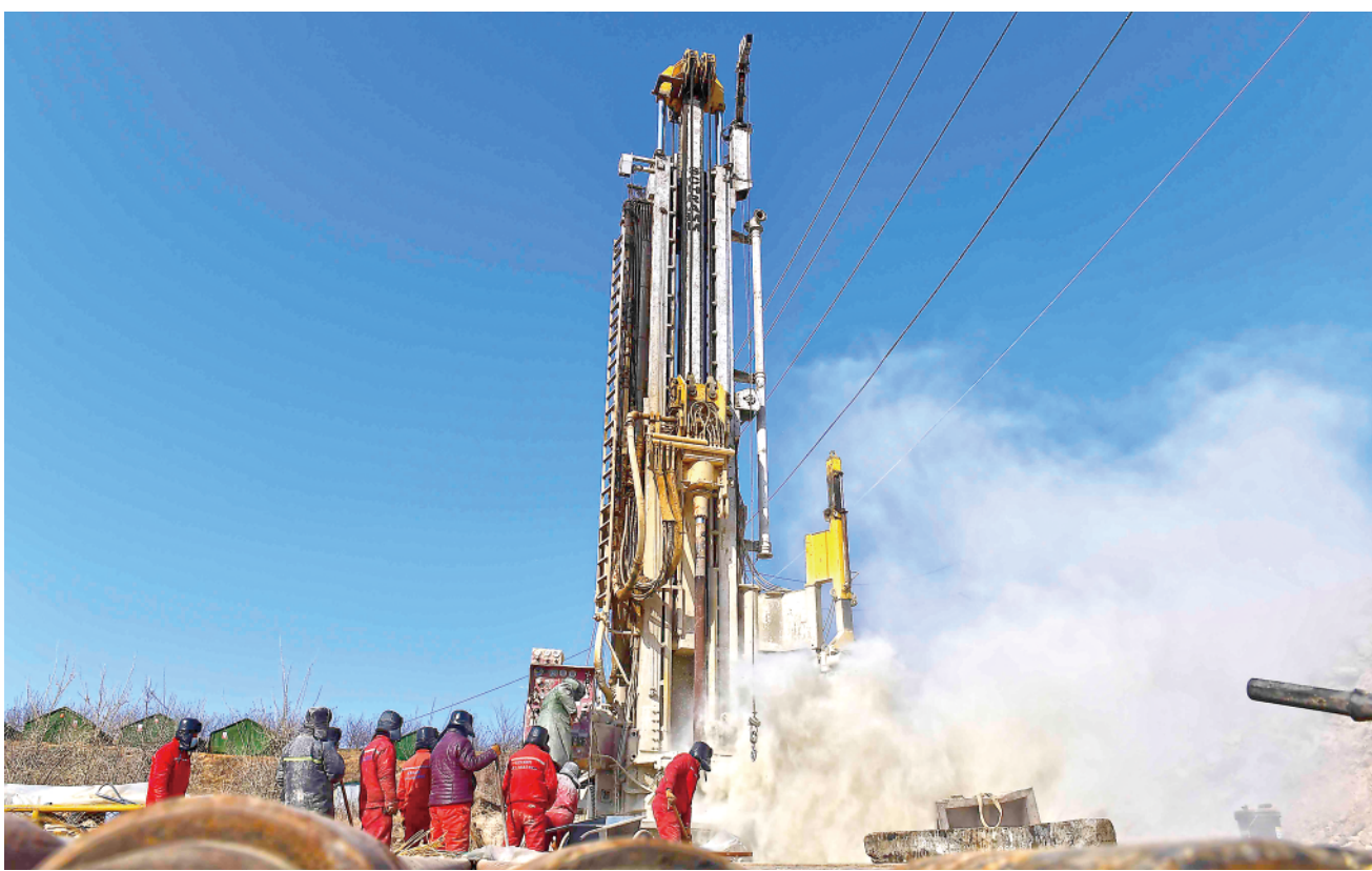
1月19日,救援人员在进行钻孔作业。 新华社记者郭绪雷摄
