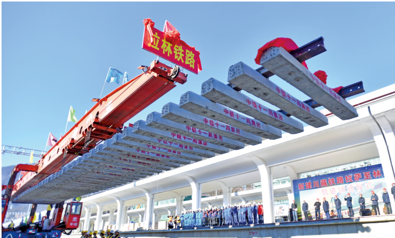
2020年12月31日,最后一排轨排落地,标志着川藏铁路拉林段全线铺轨完成。
