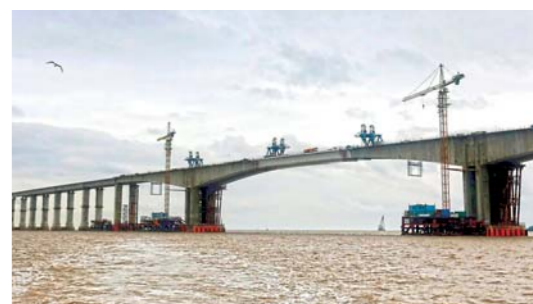
舟岱大桥三个通航孔桥全部顺利合龙
