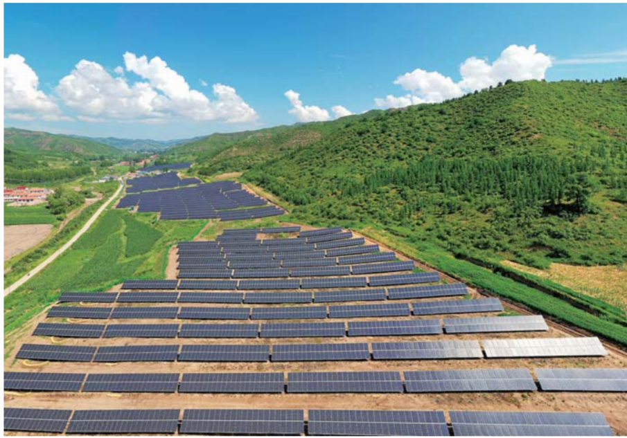
▲空中俯瞰河北省承德市围场满族蒙古族自治县牌楼乡东岔村的光伏扶贫电站(7月15日摄,无人机照片)。
