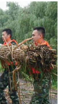
▲在江苏镇江市丹徒区世业镇先锋村西南大堤,中国安能集团第二工程局常州分公司防汛前置备勤队员准备将捆好的芦苇放在江堤边(7月17日摄)。
