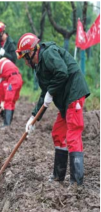
▲在江苏镇江扬中市长江大堤新坝镇新宁村段,中国安能集团第二工程局常州分公司防汛前置备勤队员在填充反滤料(7月17日摄)。
