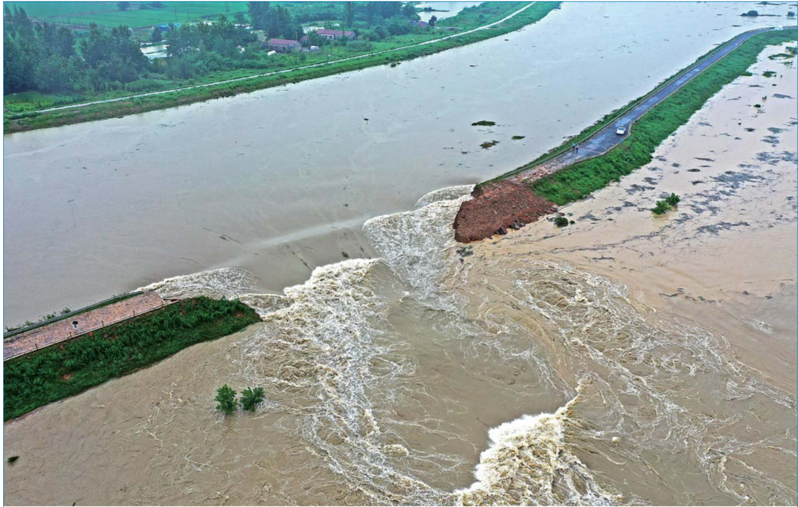
▲7月19日在滁河流域全椒县荒草二圩拍摄的被爆破开的滁河大堤缺口(无人机照片)。 19日凌晨3时许,接连两次震耳的爆破声后,安徽滁河大堤破开两处缺口,浑黄的滁河水涌入堤内的荒草二圩和荒草三圩蓄滞洪区,顷刻间绿野变成汪洋。这是继18日启用东大圩蓄洪区后,安徽又启用的两处蓄洪区。 新华社发(沈果摄)
