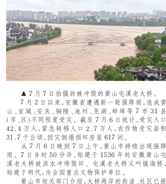
七月七日拍摄的被冲毁的黄山屯溪老大桥。
