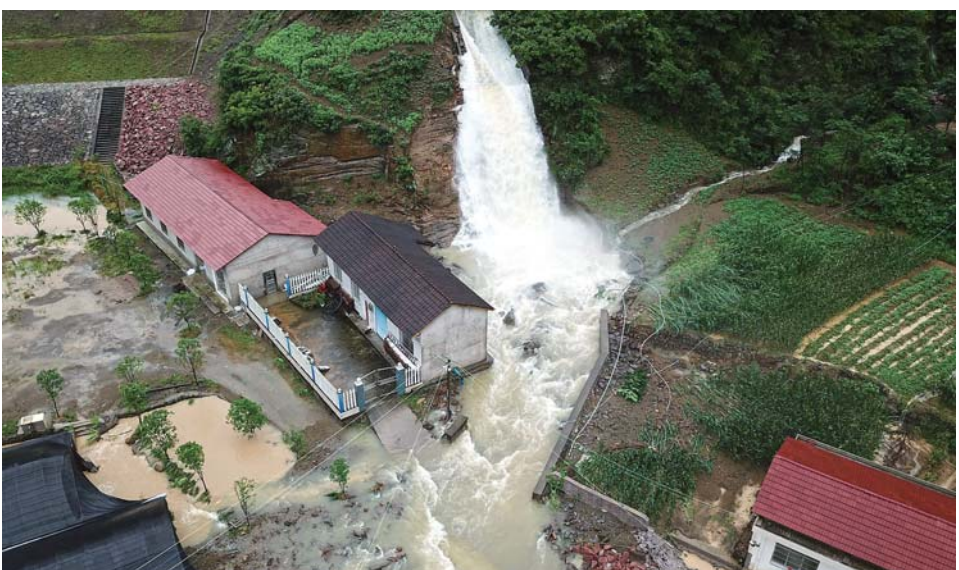
亩的基地厂房已浸泡在水中,防护设施被冲毁。“里面的15万只商品蛙和100多万只幼蛙都被水冲走了,加上村里另外被损毁的310亩稻田养蛙基地,损失超过了2000万
