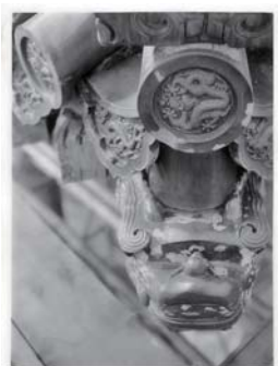
▲北平故宫太和殿下檐东南角套兽俯视图。 ▶北平故宫太和殿须弥座石刻测稿。
