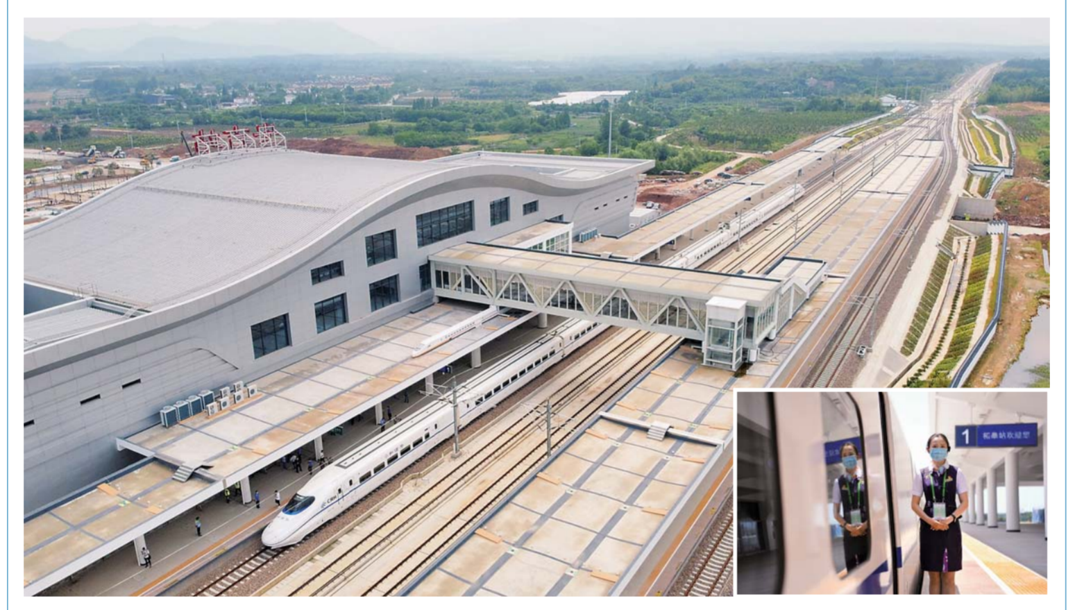
大图：5月27日，试运行检查确认列车停靠在商合杭高铁安吉站(无人机照片)。小图：5月27日，试运行检查确认列车乘务人员在商合杭高铁柘皋站。
