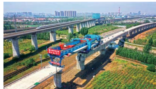
银西高铁完成全线箱梁架设
