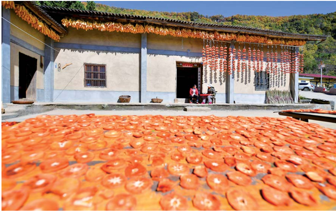
▲2018年10月拍摄的安康汉滨区茨沟镇西沟村村民方献林家里经过改造翻新的房屋和院子。
