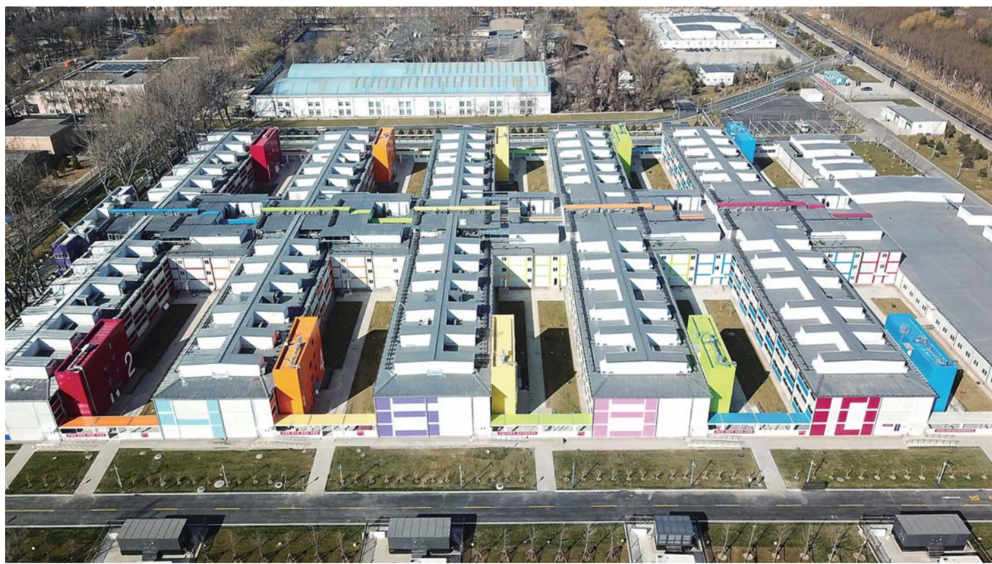
▲3月17日拍摄的北京小汤山医院局部(无人机照片)。记者3月17日从北京市疫情防控新闻发布会上获悉,从3月16日17时至24时,小汤山医院接收来自首都机场待筛查人员35人,其中来自英国的1例已诊断为确诊病例。北京小汤山医院改造和新病区建设工程3月15日顺利完成,建设床位1600余张。目前北京已从22家市属医院选派600余名医护人员进驻小汤山医院,涵盖呼吸、感染、重症、急诊、儿科、中医、检验、放射、药剂等专业。
