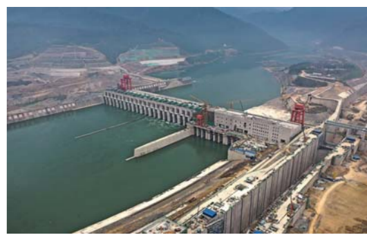
2月29日,广西大藤峡水利枢纽工程左岸7号水轮发电机组转子按计划如期吊装。 新华社记者曹伟铭摄
