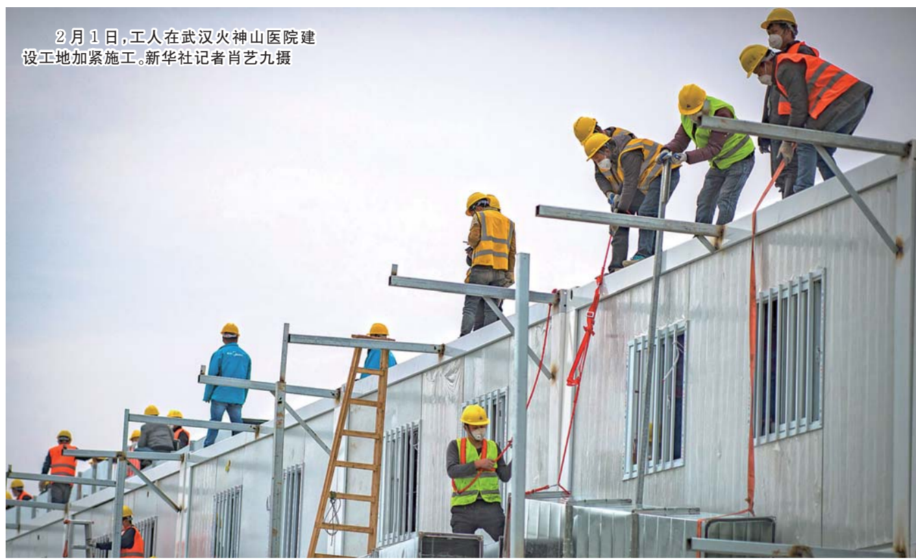
2月1日，工人在武汉火神山医院建设工地加紧施工。新华社记者肖艺九摄
