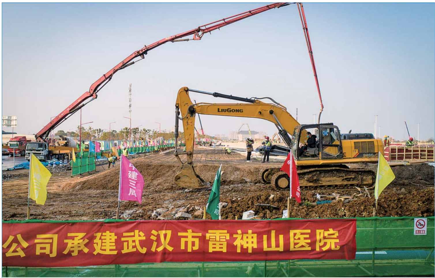
▲1月30日,在武汉雷神山医院建设工地,大型机械加紧施工(无人机照片)。截至到1月30日中午12时,由武汉地产集团组织实施建设的武汉雷神山医院项目总体建设进度完成40%。医疗隔离区防渗膜已基本铺设完成,到场1500间板房已全面开始场外拼装改装,下一步将全面开展板房吊装作业。医护人员生活区7栋宿舍完成板房结构施工,同步进行水电安装。新华社记者肖艺九摄
