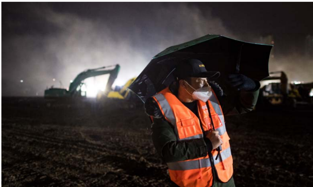
1月24日，除夕夜，武汉火神山医院建设工地灯火通明，建设团队加紧建设。武汉市参照2003年抗击非典期间北京小汤山医院模式，正在蔡甸区建设火神山医院，集中收治新型冠状病毒感染的肺炎患者。新医院计划于2月3日建成。新华社记者肖艺九摄
