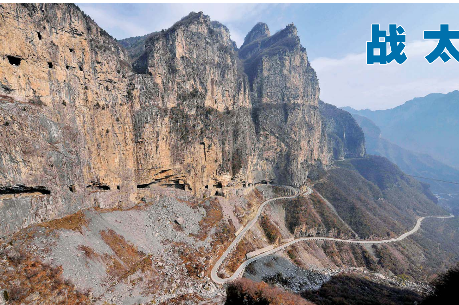
▲在太行山区山西省陵川县锡崖沟村的峭壁上，有一条被当地人称为“天路”的挂壁公路，公路全长7.5公里，从1962年开始修建，历时30年开凿建成。挂壁公路通车前，位于太行山深处的锡崖沟村村民前往县城要花大半天时间。如今，锡崖沟挂壁公路已成为距县城不到一个小时车程的旅游景区。新华社记者詹彦摄
