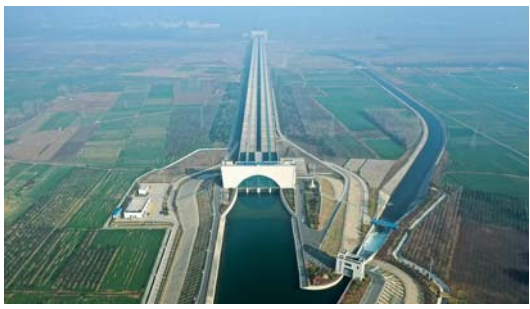
冬日俯瞰河南沙河渡槽
