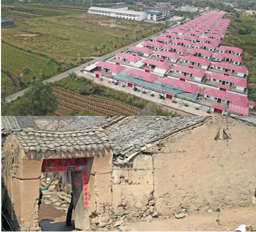
上图：现在的渭源县元古堆村村貌（2019年9月摄）。下图：脱贫前的渭源县元古堆村一处民居（2013年3月摄）。新华社记者范培坤摄
