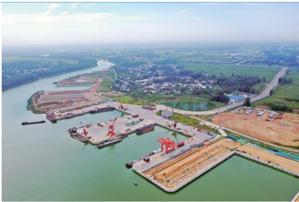
左图:7月31日,货船停靠在周口中心港码头。 新华社记者顾立林摄 右图:7月31日无人机拍摄的周口中心港码头。 新华社记者李嘉南摄 近年来,河南省周口市依托地理优势,推进沙颍河航道升级改造,疏通内河航运,以港口多式联运建设为切入点,大力发展临港经济。从周口中心港出发的船舶可经沙颍河至淮河、京杭大运河进而驶入长江,实现了内陆城市的商品货物通江达海。
