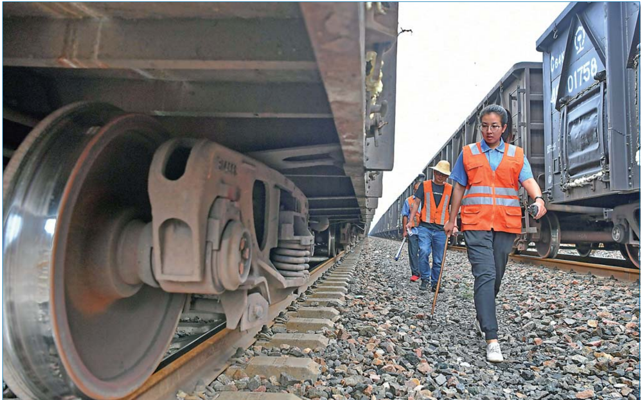
▲7月9日,中国铁路太原局集团有限公司大同工务段巡检员杨泽华(前)和工友们在大秦铁路上巡检。近日,随着气温逐渐升高,线路防胀成为大秦铁路的养护重点工作。每天沿线都有超过400位巡检员为轨道“看病”,为每天开行的90余列重载列车提供安全保障。 新华社记者曹阳摄
