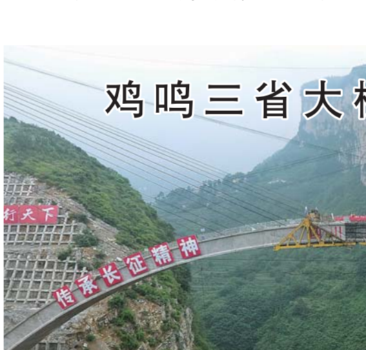
▲7月7日，位于川滇黔三省交界处的鸡鸣三省大桥主拱圈顺利合龙，为2019年底建成通车奠定了坚实基础。该桥建成后解决三省交界一带数十万群众的出行难题。
