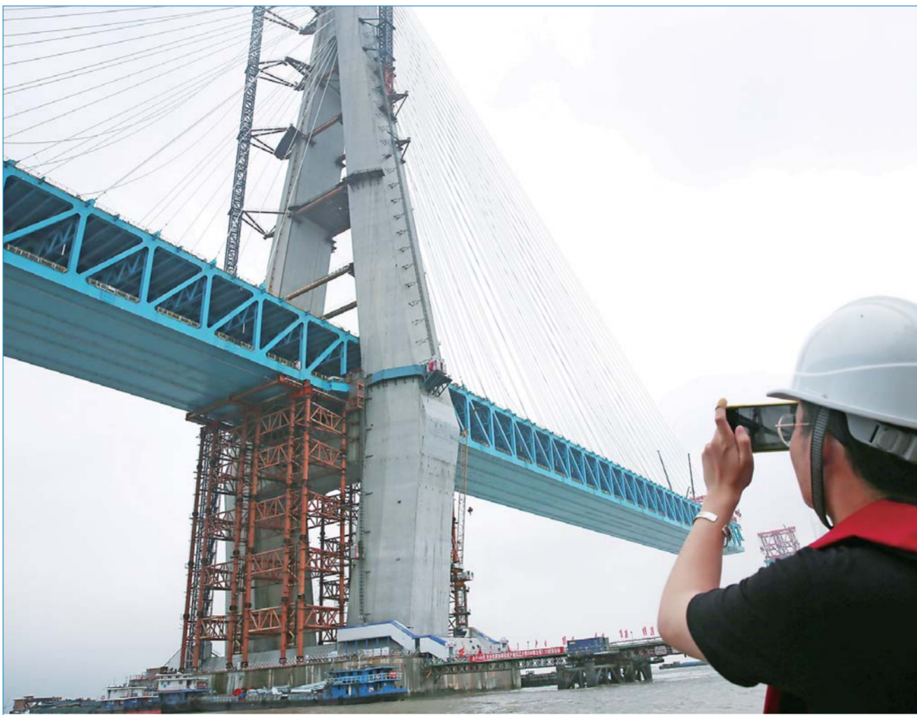
▲6月27日,工作人员在拍摄沪通长江大桥南主塔。新华社发(许丛军摄)
