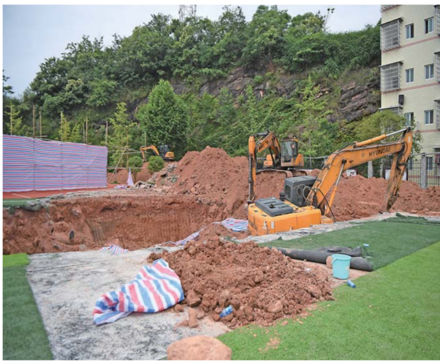
▲这是6月21日拍摄的湖南新晃侗族自治县一中操场挖掘现场。 新华社记者薛宇桐摄
