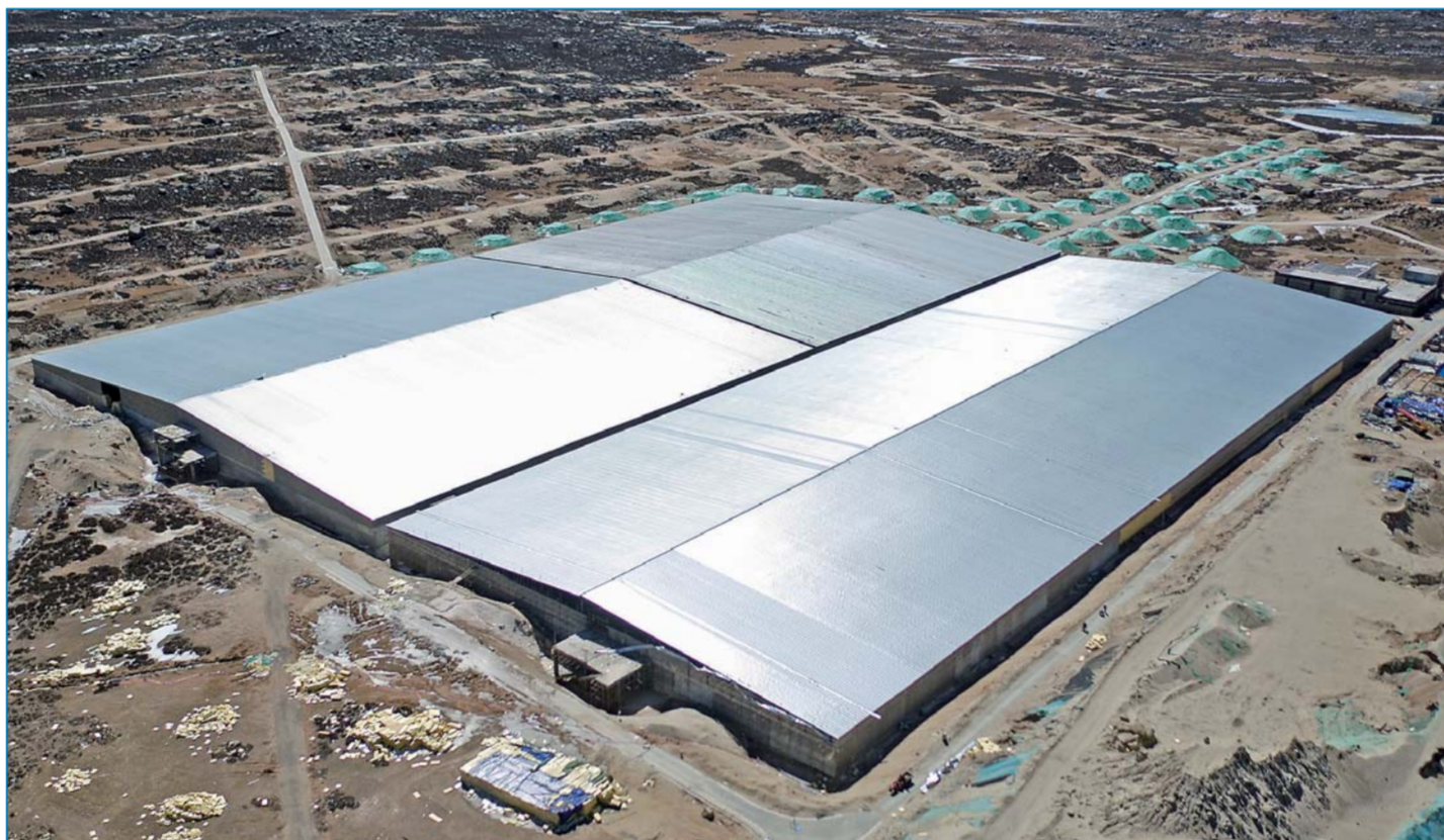
▲俯瞰水切伦科夫探测器阵列(2月22日无人机拍摄)。
