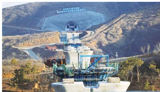
朝凌客专黑石沟隧道贯通
