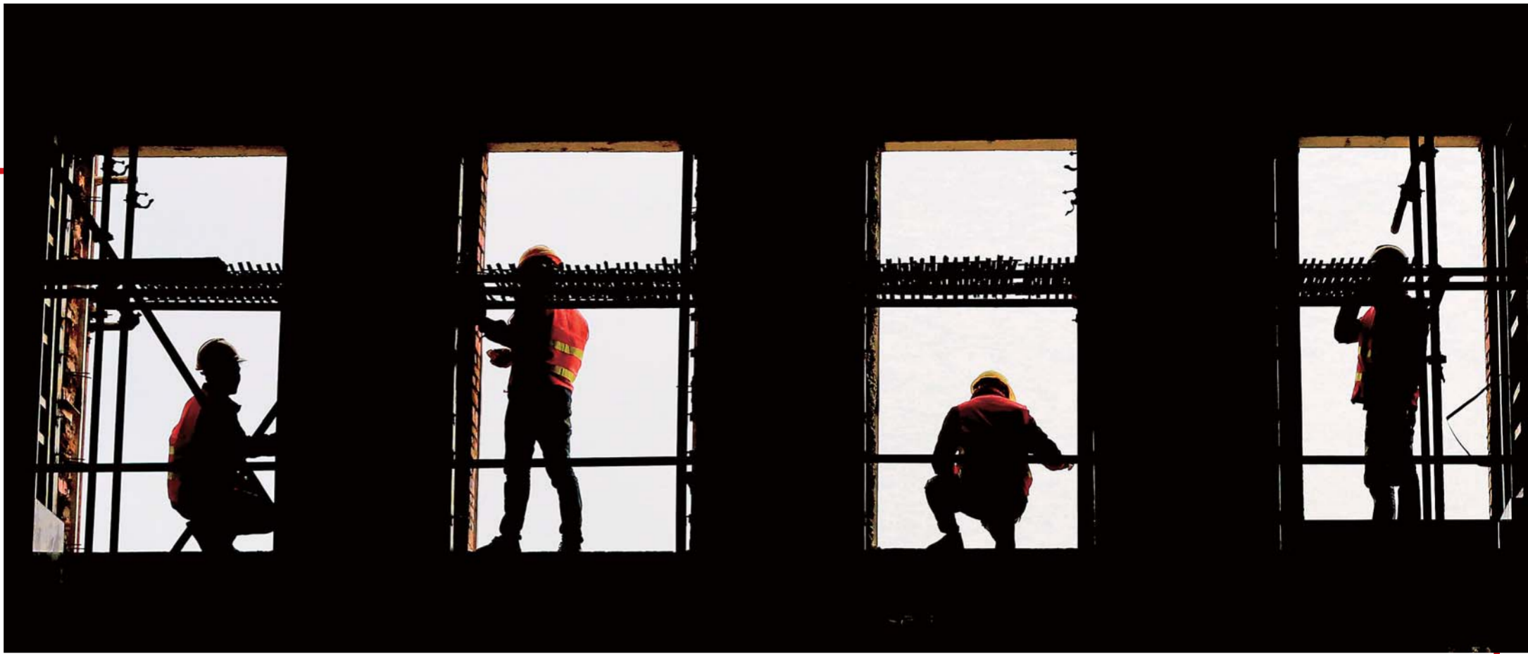
▲2月5日，在位于江西吉安市的昌赣客专峡江站建设工地，工人在施工。新华社发(陈福平摄)
