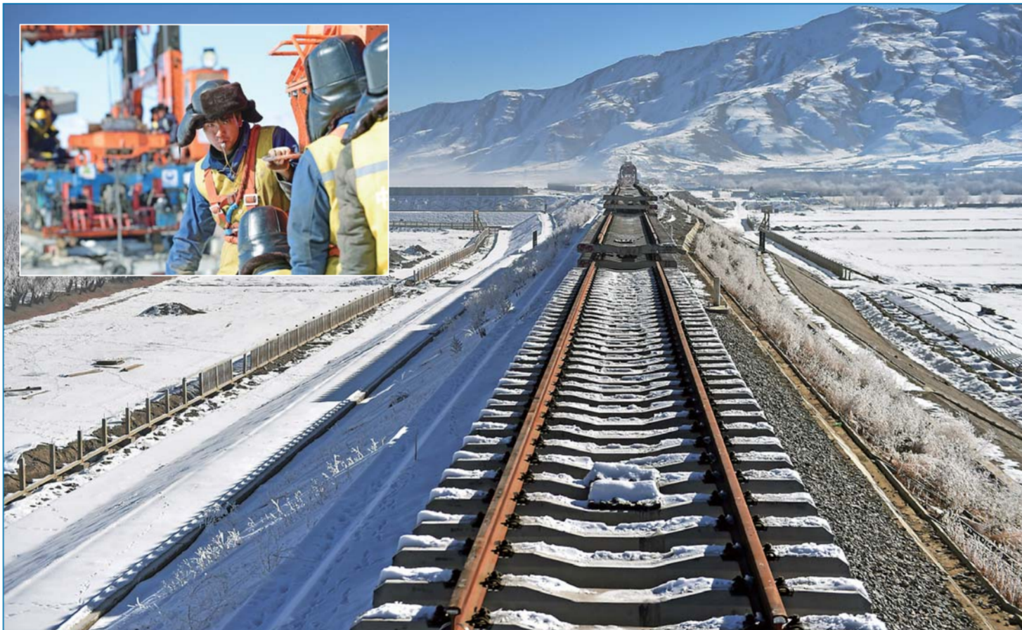
大图:12月23日,工人在川藏铁路拉林段施工。
