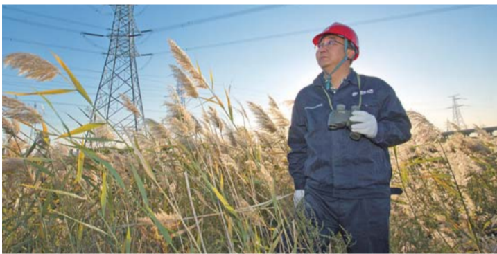
张黎明在天津滨海新区西中环快速路施工现场(2016年10月31日摄)。新华社发
