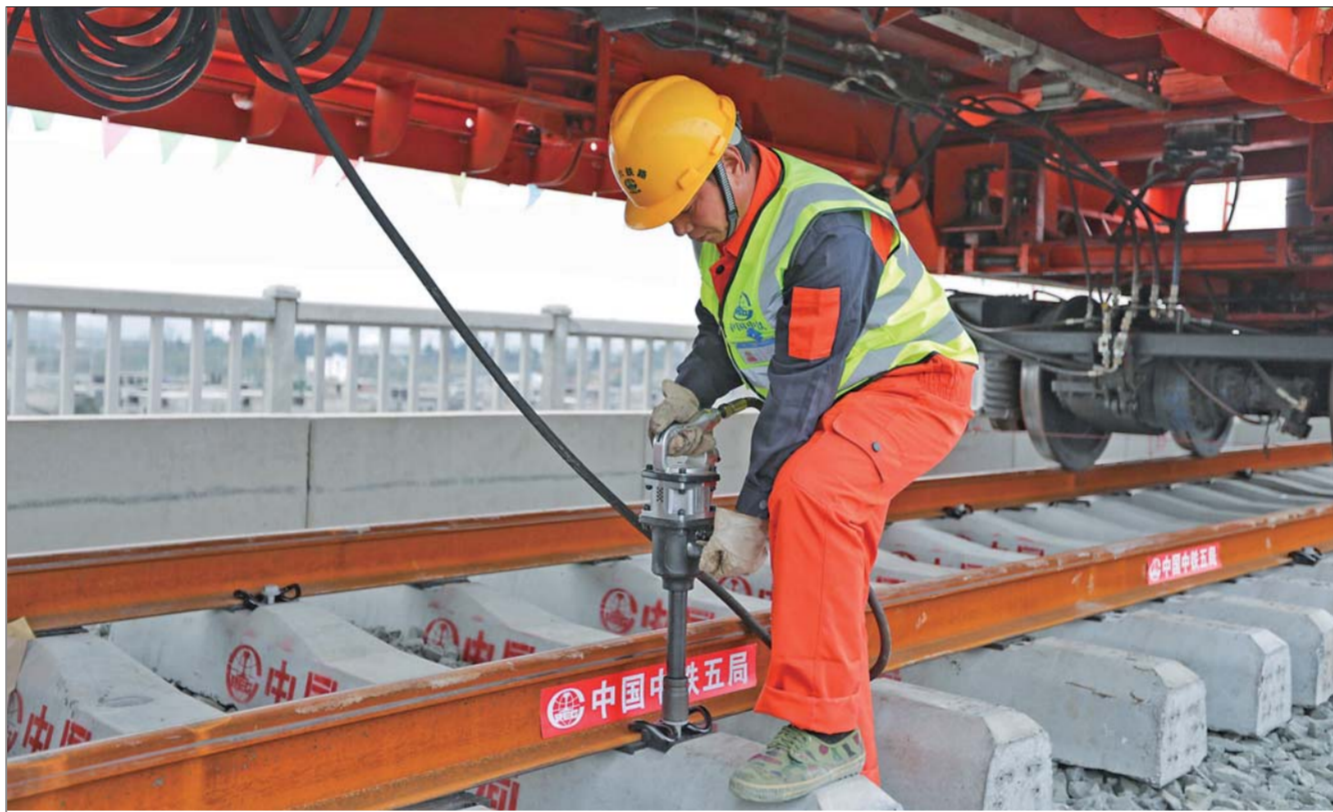
安六铁路开始铺轨
