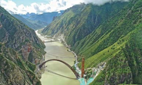
川藏铁路藏木特大桥合龙
