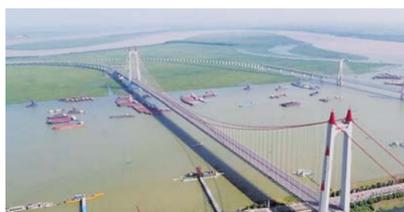
杭瑞高速洞庭湖大桥全长23.1公里,其中主桥长2.39公里,剩下的20多公里是穿越洞庭湖湿地的引桥,这样的设计最大程度避免了桥梁建设对于湿地生态环境的影响。
