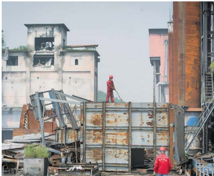
▲工人在湖北香溪化工有限公司宜都分公司拆除现场作业(4月30日摄)。 新华社记者肖艺九摄
