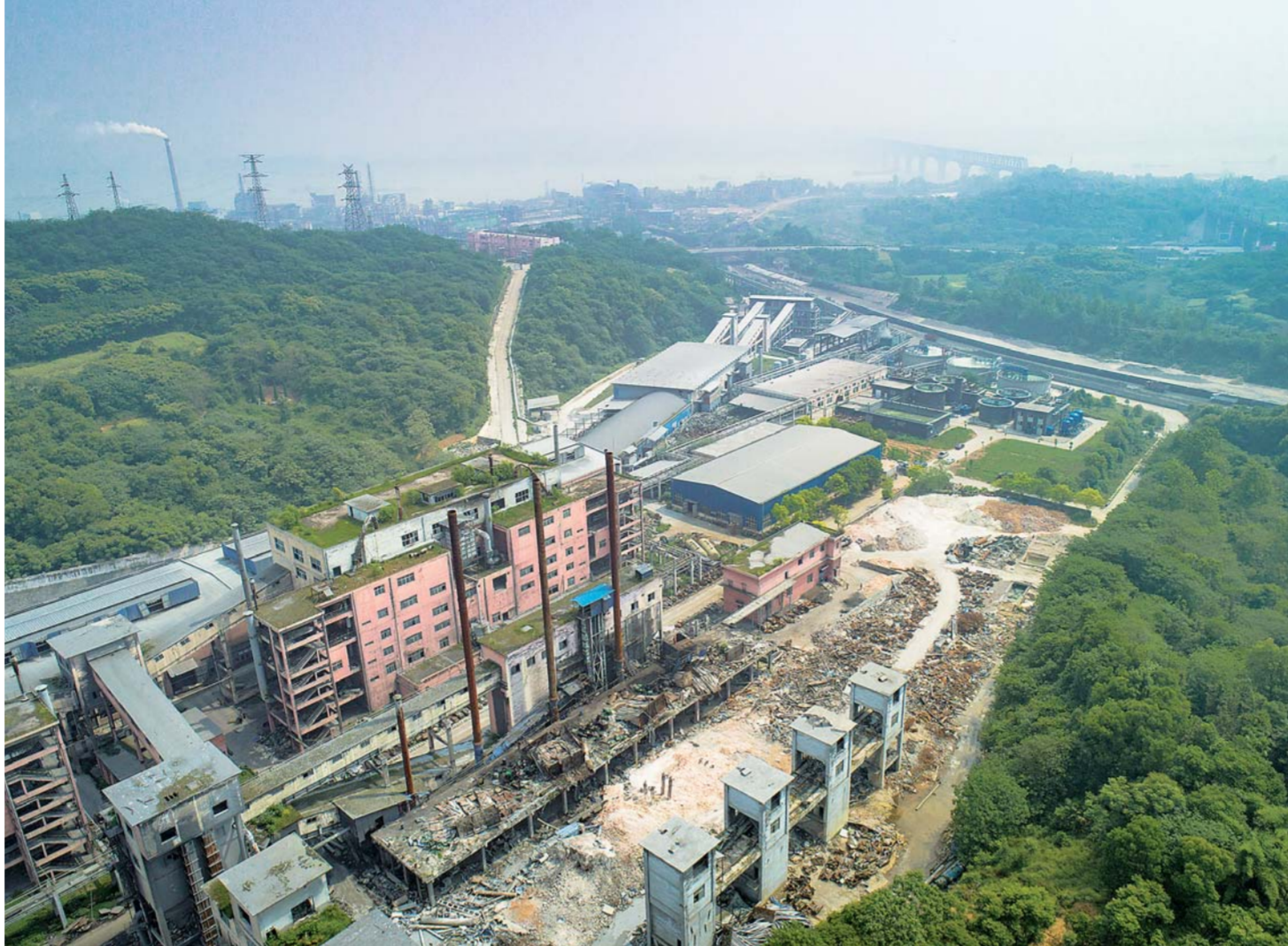
▲湖北香溪化工有限公司宜都分公司拆除现场(4月30日无人机拍摄)。 新华社记者肖艺九摄
