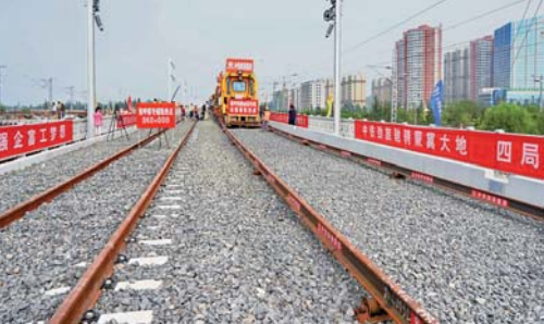
张呼客运专线铺轨完毕
