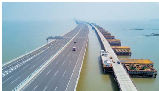
泉州湾跨海大桥紧张施工
