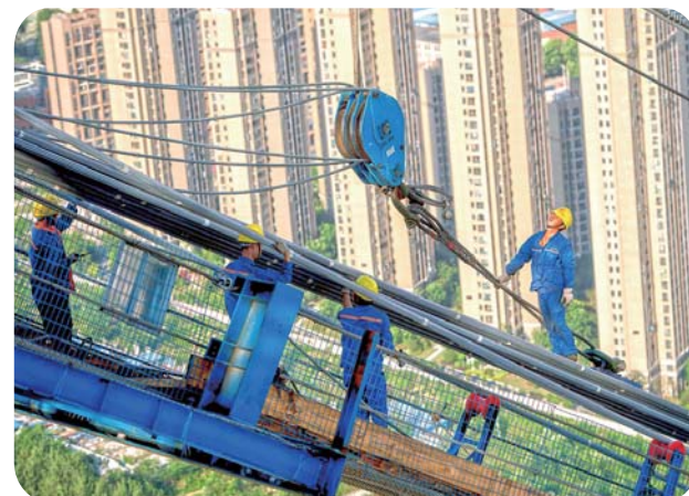
▲工人对引桥部分进行主缆架设作业(6月25日摄)。
