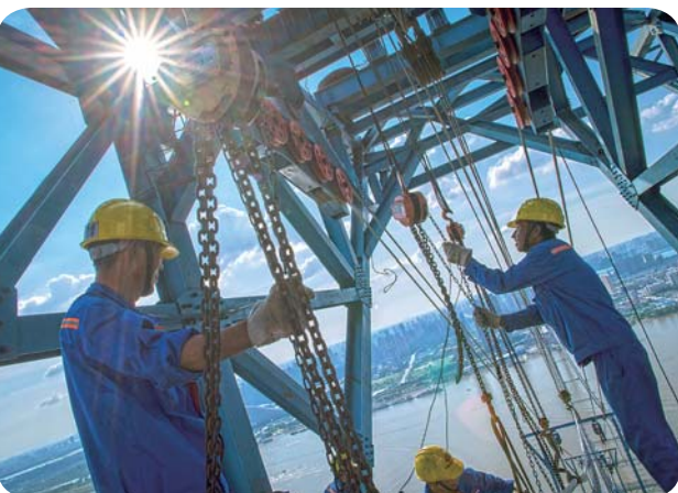
▲工人们在南岸进行架设主缆作业(6月25日摄)。
