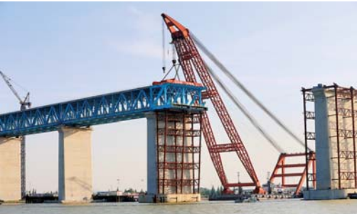
“千吨钢梁”架设成功 6月1日，由中铁大桥局施工的沪通长江大桥首个超千吨大节段钢梁架设成功。 新华社发（许丛军摄）
