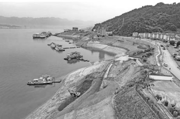
▲5 月 29 日,工人在秭归县茅坪镇银杏沱水域库岸生态修复工程现场施工(无人机航拍)。 位于三峡库区的湖北省秭归县加速库岸生态修复,2016 年启动县城凤凰山至滚装码头库岸治理工程,通过回填放坡、方石护坡、植被绿化等方式,目前已修复长江岸线 12.6 公里。 新华社发(王罡摄)
