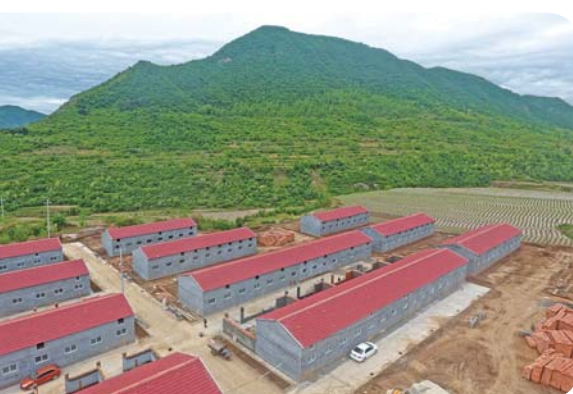
▲壶关县树掌镇易地扶贫搬迁安置新区已基本完工（5月24日无人机拍摄）。
