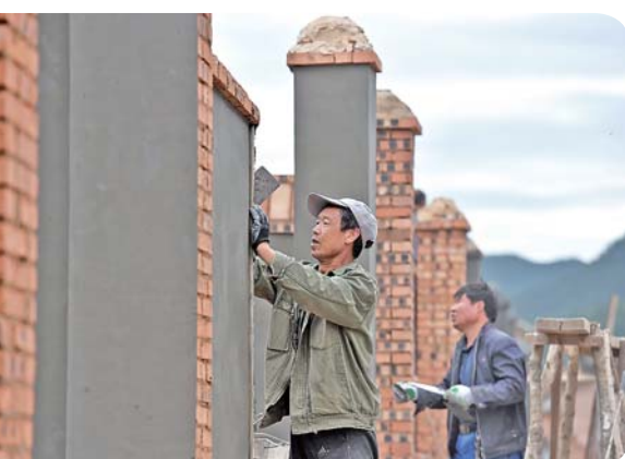
▲5月24日，施工人员在山西省壶关县树掌镇易地扶贫搬迁安置新区施工。
