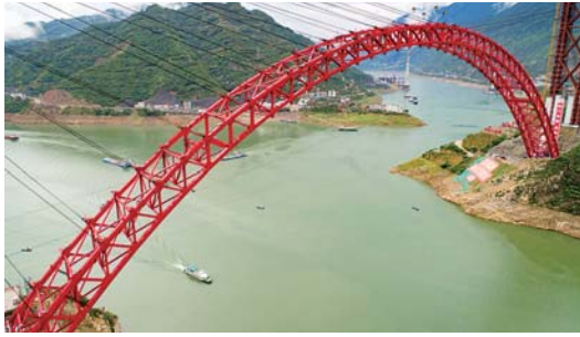
香溪长江大桥主拱合龙
