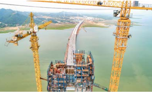
鄱阳湖二桥主塔即将封顶
