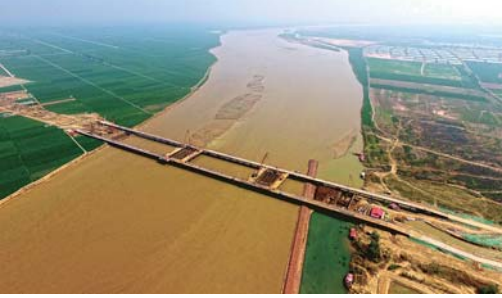
郑济高铁郑州黄河特大桥全面开工
