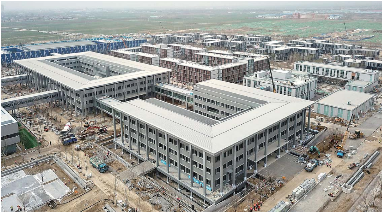
▲这是雄安市民服务中心施工现场(3月27日无人机拍摄)。
