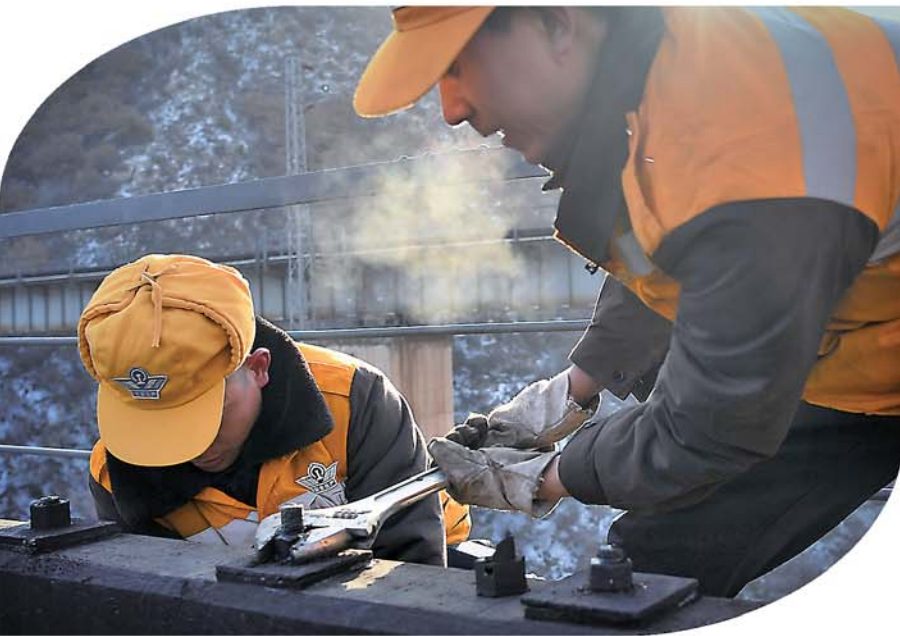
左上图：1 月 31 日，李玉斌在整理悬空作业时使用的保险绳。 左下图：1 月 31 日，李玉斌（右）和工友在复紧桥梁枕木螺栓。
