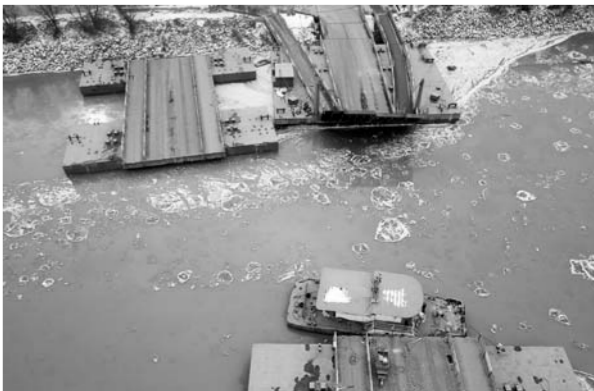
▲1月30日,漓凌通过黄河济南段一处部分拆除的浮桥。受持续冷空气影响,黄河济南段近日出现大面积漓凌。为保证黄河河道安全,1月29日下午开始,黄河济南段部分浮桥被陆续拆除。新华社记者徐速绘摄
