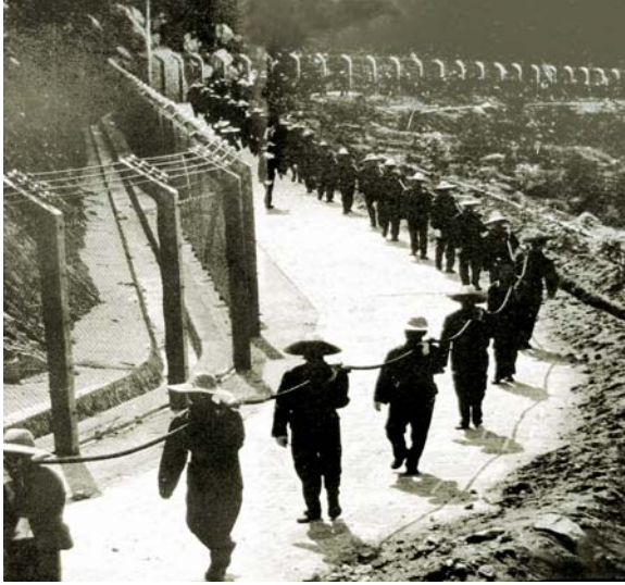
▲广东边防总队官兵铺设深圳经济特区管理线电缆(资料照片)。
